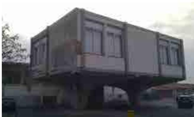
elettrico, oltre a varie crepe nell'intonaco esterno. Si è reso pertanto necessario intervenire, prima della stagione invernale, con la sistemazione del tetto, attraverso la posa di un pacchetto isolante di 10 cm e con una doppia guaina bituminosa. Verranno sistemate poi le crepe all'intonaco esterno e al soffitto della sala con conseguente ritinteggiatura. La spesa prevista per le opere è di € 15.000.
